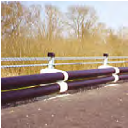
Bild 4 Längsgående stolpskydd (Mototub) monterad på ett vajerräcke.
