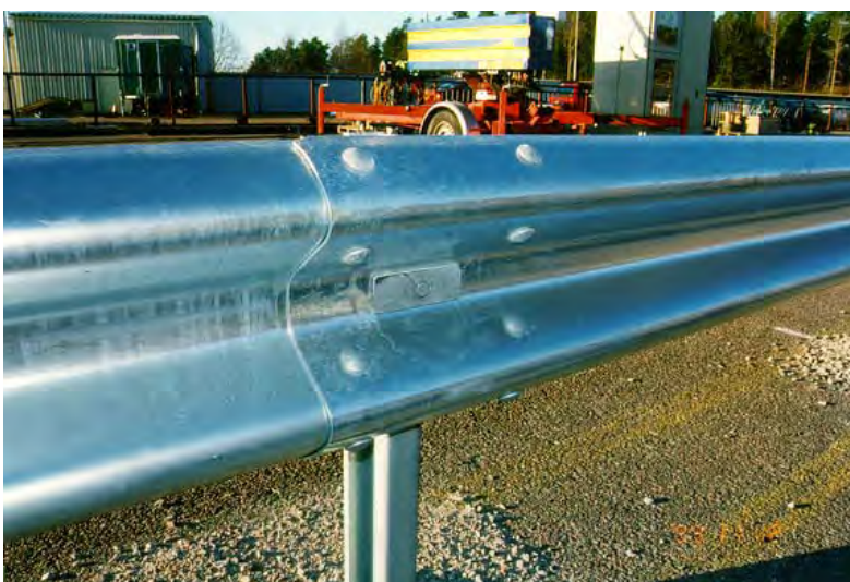
Figur 2 Typiskt W-balkräcke, ett EU2 med sigma-ståndare.
