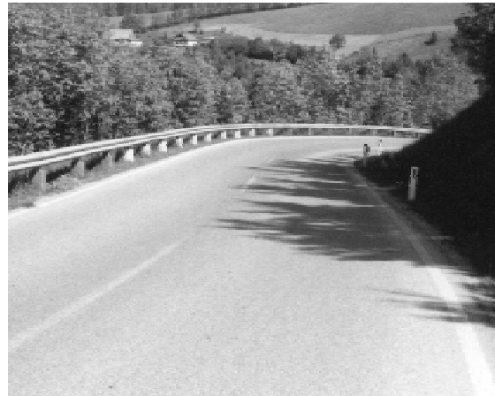
En österrikisk väg där vägräcket utrustats med stötdämpande skydd i polystyren
