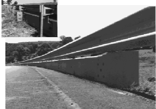
En fransk väg med ett andra lägre räckesskydd
