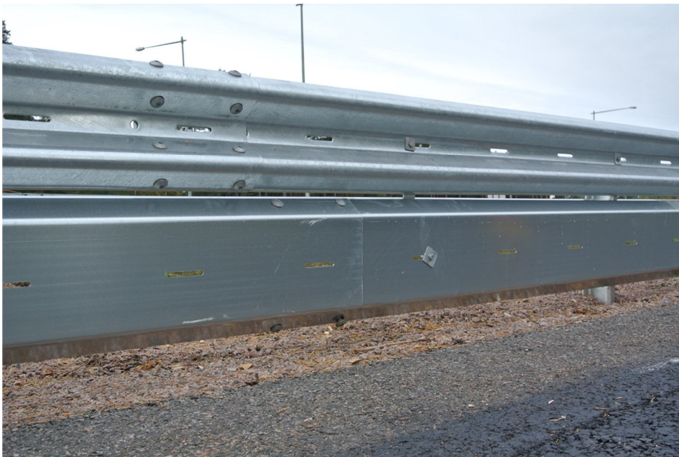
Εικόνα 3. Μπαριέρα με προφίλ W και πρόσθετα προστατευτικά MPS, τοποθετημένα στην έξοδο στον Ε4 έξω από το Gävle, το 2014.
