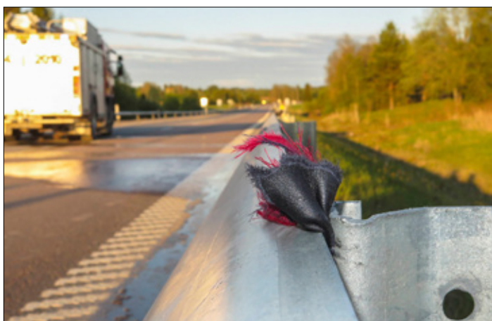
Ovan: Skyddsutrustning och kroppsdelar fastnade i utstickande delar på räcket och vållade mycket allvarliga skador på MC-föraren. Foto: Ingmar Reslegård. Nedan: Montering av underglidningsskydd, avfart E4 Gävle.
