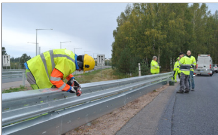
Ovan: Skyddsutrustning och kroppsdelar fastnade i utstickande delar på räcket och vållade mycket allvarliga skador på MC-föraren. Foto: Ingmar Reslegård. Nedan: Montering av underglidningsskydd, avfart E4 Gävle.
