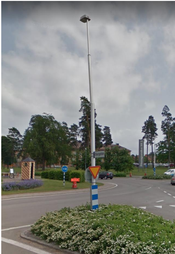
Eftergivlig stolpe med många skyltar som kan påverka dess funktion.
