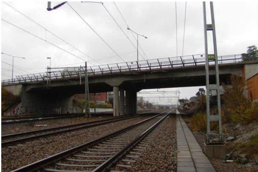
Figur 8-B Exempel på bro med för svagt räcke
