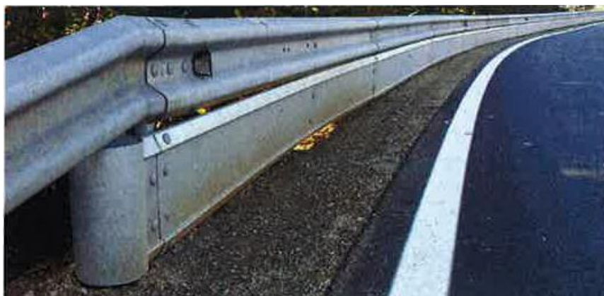
Figur 8-D Exempel på räcke med underglidningsskydd
