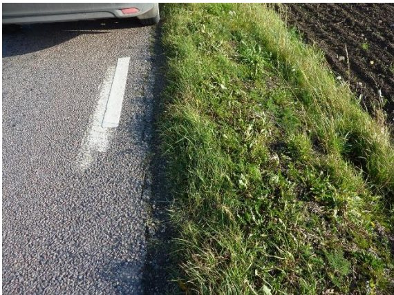
Figur 47. Till vänster enstaka lösa gruskorn på vägytan. Till höger stödremsa av asfaltsgranulat.
