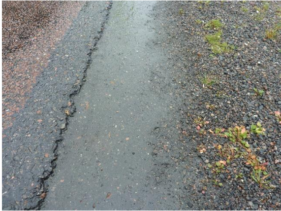
Figur 41. Stödremsa förseglad av snabelbil. Ytskiktet kan bli asfaltlikt och tät.
