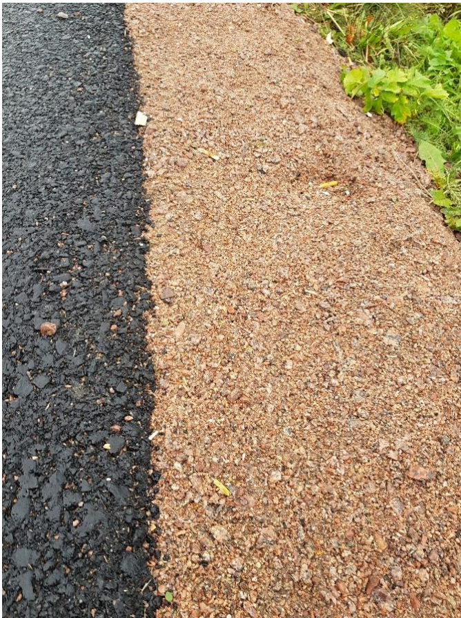
Figur 55. Nylagd obunden stödrensa intill nylagd asfalt.
