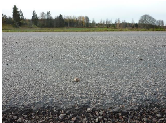
Figur 53. De övre bilderna visar grässvål ända in till beläggningskant. Nere till vänster visar stödransa av asfaltsgranulat. Nere till höger visar enstaka lösa gruskorn på beläggningsytan.
