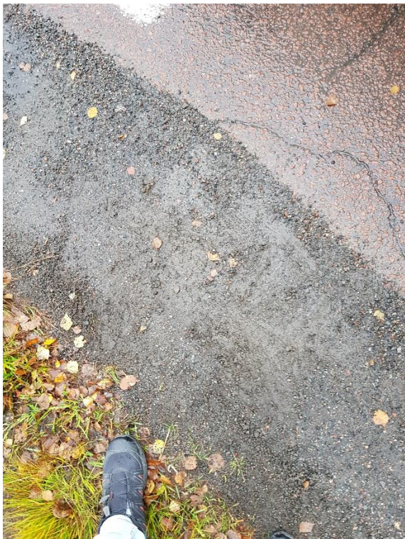
Figur 42. Beläggning med röd sten, svart bitumenhaltig stödremsa och en 44,5a i gröna gräset.
