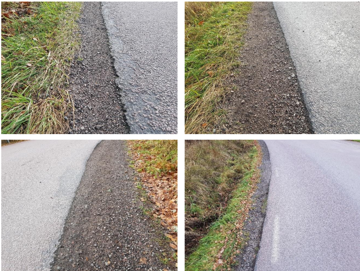
Figur 51. Exempel på stödremsa av asfaltsgranulat med olika bredder. På bilden nere till höger syns gräns för komplettering i kurvan.
