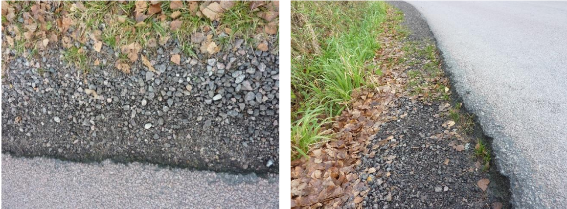
Figur 54. Till vänster grusigt exempel asfaltsgranulat. Till höger tydlig nivåskillnad mellan stödrensa och belägningskant.
