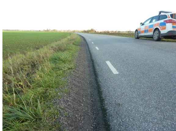
Figur 48. De övre bilderna visar gräskant nära inpå beläggningkant. De nedre visar nivåskillnader mellan stödremsa och beläggningkant.
