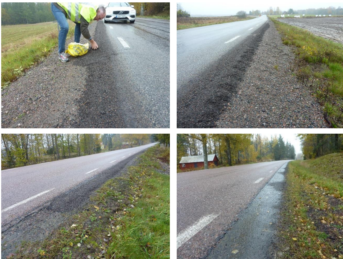
Figur 39. Uppe till vänster provtagning av stödremsa, uppe till höger nylagd stödremsa av emulsionsblandat grus. Nere till vänster gräns för komplettering av stödremsa. Nere till höger av förseglad stödremsa (av s.k. kallad snabelbil).
