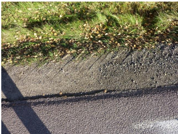
Figur 46. Uppe till vänster lös och grusig stödremсор. Uppe till höger tydlig gräns för komplettering i utgången av kurva. De nedre bilderna visar tydliga spår från traktor i olika vyer.
