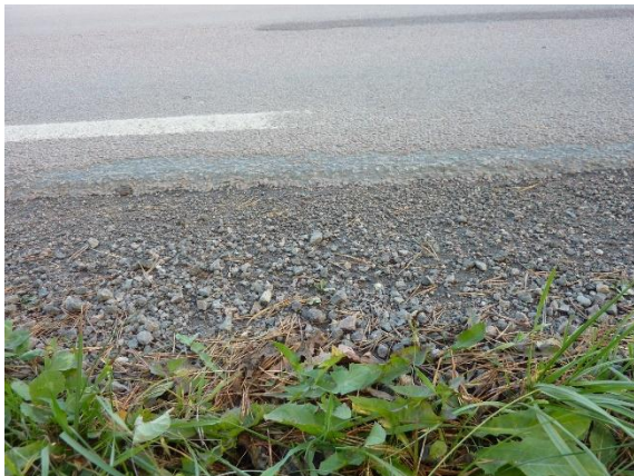
Figur 45. Lösa och grusiga stödremсор av asfaltsgranulat.
