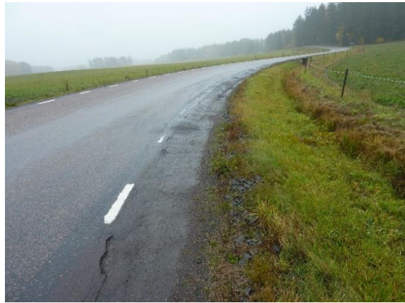
Figur 34. Till vänster snabelförstärkt stödremsa med typisk, men ofarlig, skada. Till höger Innerkurva på väg med bitumenförseglad stödremsa.
