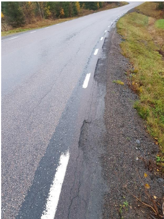
Figur 35. Snabelvariant av förstärkt stödremsa med "ofarlig" skada.
