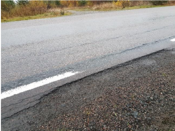
Figur 36. Snabelförstärkt stödremsa med typisk, men ofarlig, skada.
