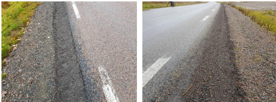
Figur 11. Relativt nylagda stödremor av emulsionsblandat grus. Till vänster anas traktorspår, till höger är bundenheten inte optimal.
