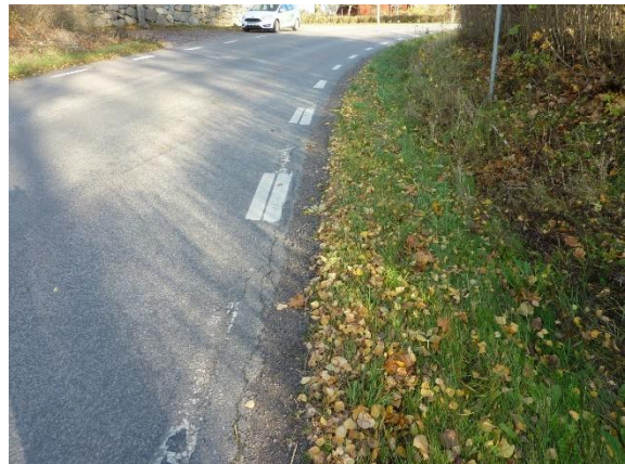
Figur 47. Till vänster enstaka lösa gruskorn på vägytan. Till höger stödremsa av asfaltsgranulat.
