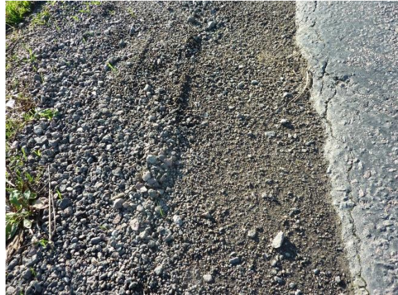
Figur 47. Till vänster enstaka lösa gruskorn på vägytan. Till höger stödremsa av asfaltsgranulat.
