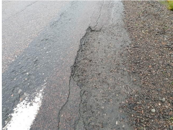
Figur 36. Snabelförstärkt stödremsa med typisk, men ofarlig, skada.
