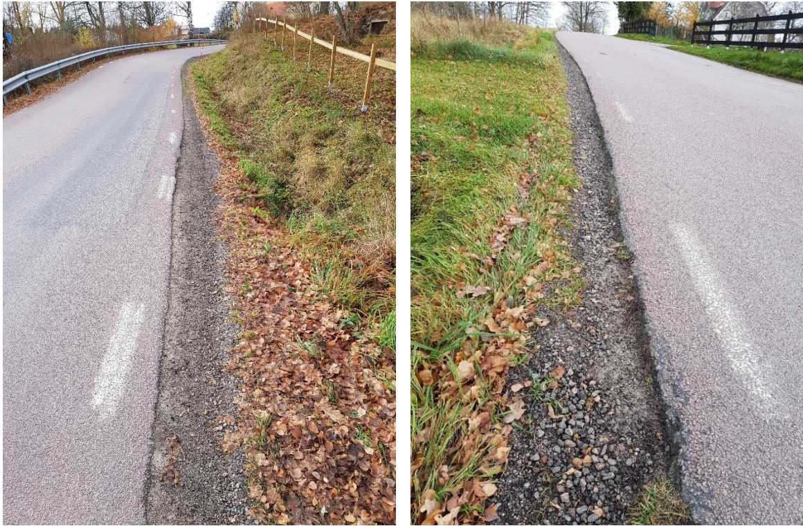
Figur 50. Till vänster acceptabel stödremsa. Till höger bortkörd/nedtryckt stödremsa med nästan bara grova korn kvar.
