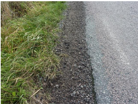
Figur 53. De övre bilderna visar grässvål ända in till beläggningskant. Nere till vänster visar stödransa av asfaltsgranulat. Nere till höger visar enstaka lösa gruskorn på beläggningsytan.
