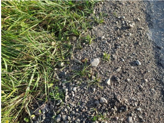
Figur 45. Lösa och grusiga stödremсор av asfaltsgranulat.
