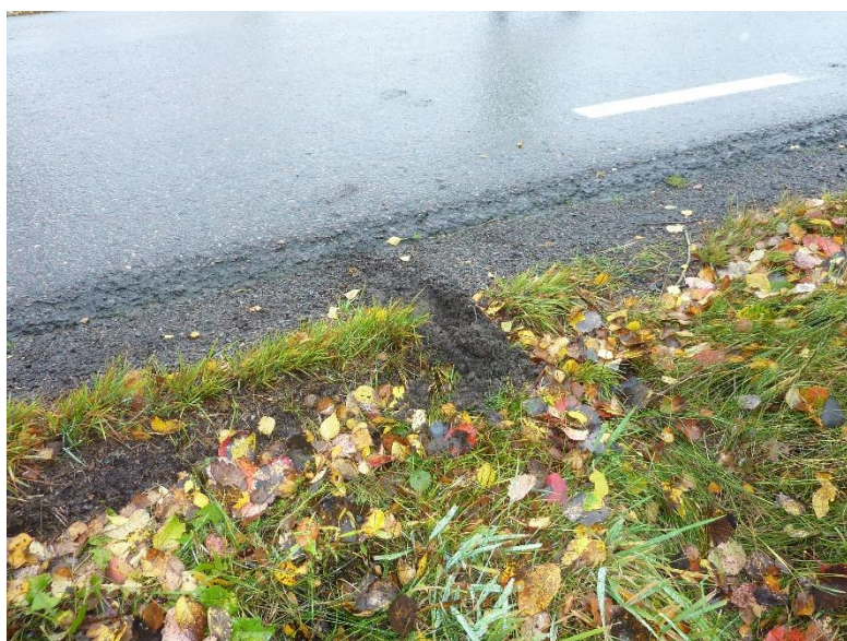
Figur 12. Nedtryckt stödremsa med gräsvål. Spår av sparktest” för kontroll av bärighet syns.
