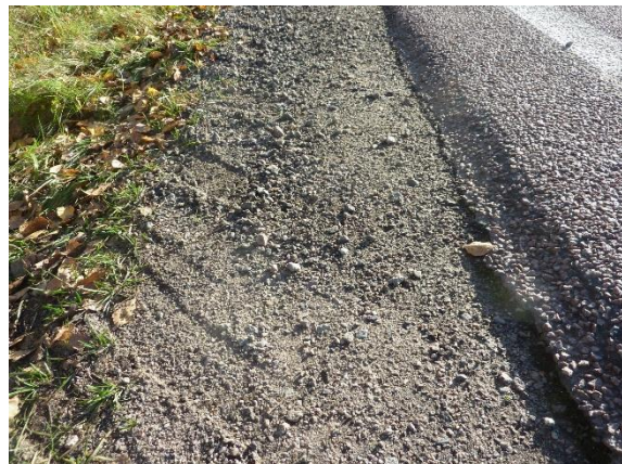
Figur 46. Uppe till vänster lös och grusig stödremсор. Uppe till höger tydlig gräns för komplettering i utgången av kurva. De nedre bilderna visar tydliga spår från traktor i olika vyer.
