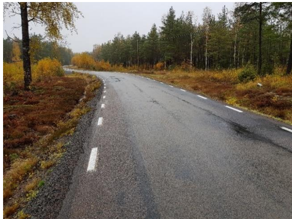
Figur 37. Till vänster väggkant med stödremsa och innerslänt mot diket. Till höger vacker vägbild från hösten.
