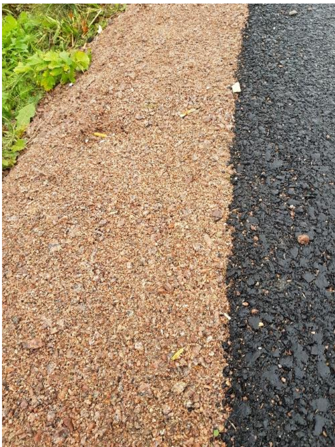
Figur 2. Nylagd obunden stödremsa vid nyasfalterd väg.
