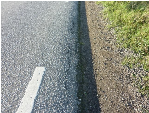
Figur 48. De övre bilderna visar gräskant nära inpå beläggningkant. De nedre visar nivåskillnader mellan stödremsa och beläggningkant.
