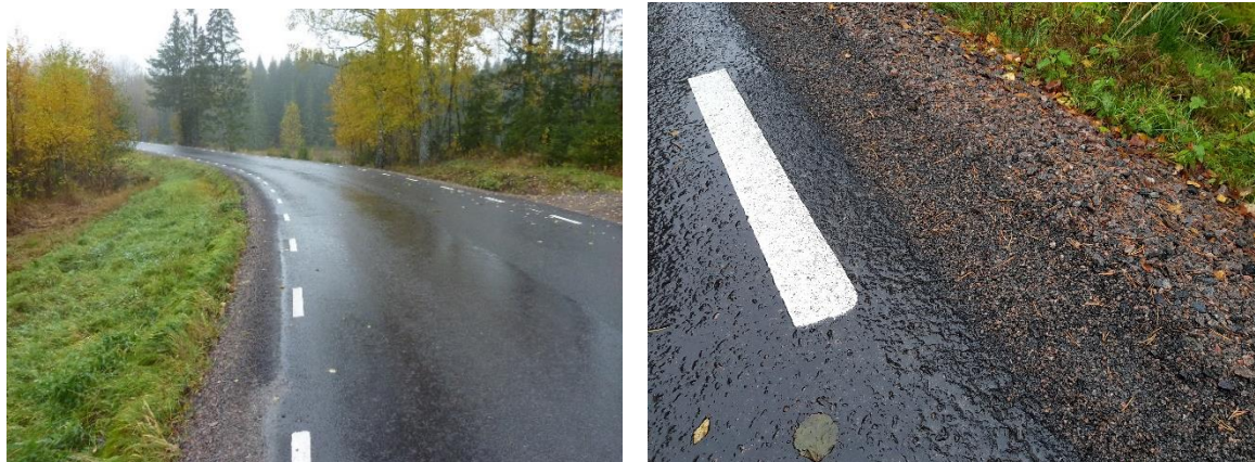
Figur 32. Nygjord bitumenförseglad stödremsa av snabelbil. Till vänster i kurva och till höger i närbild.
