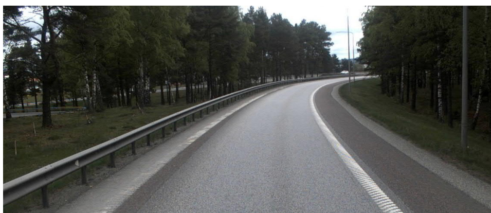
Figur 1 Exempel på trafikplatsramp med räcke i ytterkurva
