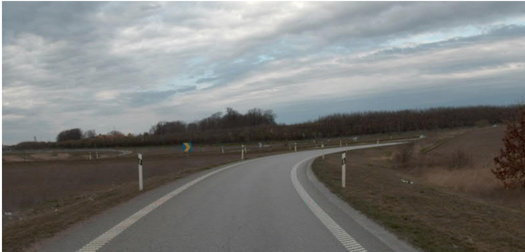
Figur 4 Exempel på ramp med vägmärket X1 i ytterkurva (trafikplats Petersborg, E6 Malmö)
