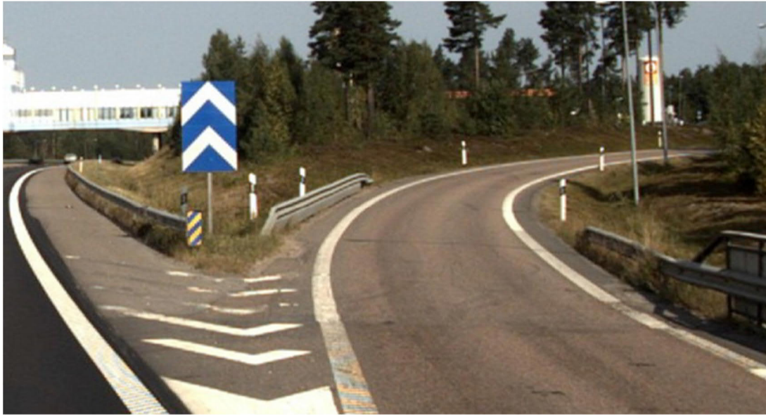
Figur 2 Exempel på redan åtgärdad trafikplatsramp (Gävle)
