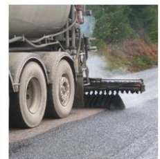
Utförande av indränkt makadam. Foto: Asfaltboken
