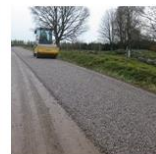
Utförande av indränkt makadam. Foto: Asfaltboken
