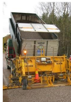
Utförande av indränkt makadam. Foto: Asfaltboken
